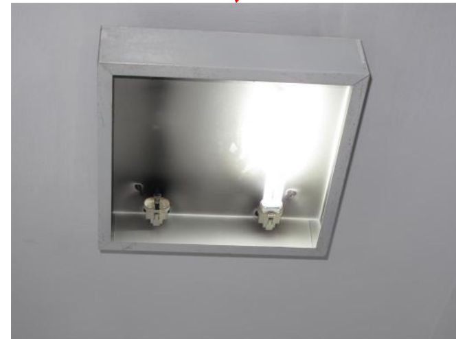
新達廣場 〔住宇大廈後樓梯〕
